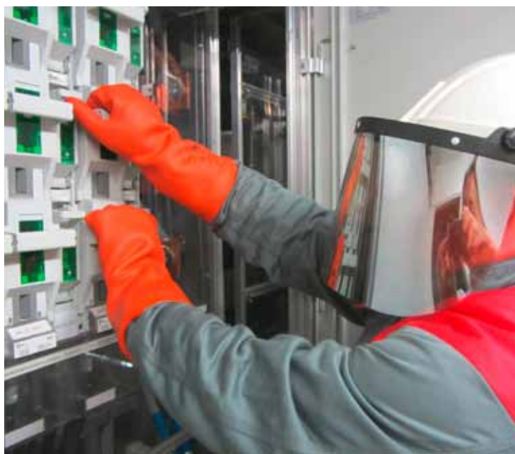
Christian Rietmann trägt beim Schalten seine persönliche Schutzausrüstung.
