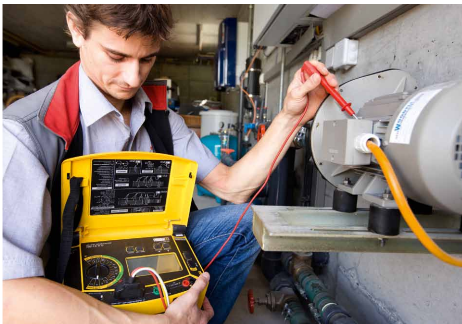
Certum-Sicherheitsberater Stefan Zeller überprüft die Elektroinstallation in der Garage.
